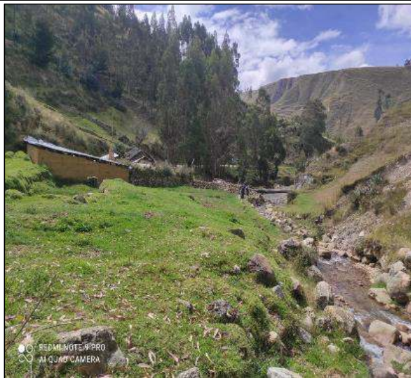
Figura 01. Se muestra la quebrada con flujo de agua constante y márgenes sin encauzamiento ni protección. Cerca del cauce se observa una vivienda construida en una zona baja, lo que la hace vulnerable ante un posible desbordamiento. La pendiente del terreno y la ausencia de defensas ribereñas incrementan el riesgo de afectación durante lluvias intensas.
