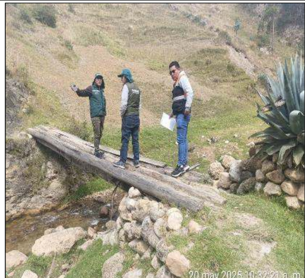
Figura 02. Se muestra un puente peatonal que da acceso al sector vulnerable. Este tipo de estructuras, en una quebrada con cauce estrecho y sin defensa ribereñas, representa un riesgo de colapso; además de desbordamiento durante crecidas, especialmente en temporada de lluvias.
